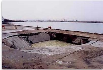
図2 岸壁内部の空洞化による上部の陥没
