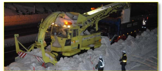
図-5 現道試行状況
