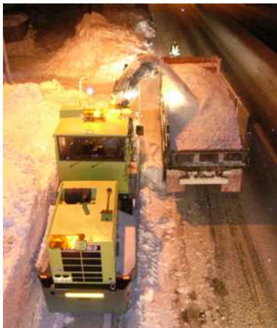
運搬排雪作業
