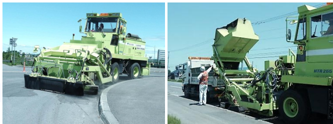
路面清掃装置での施工状況
