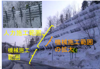
機械施工範囲の拡大
